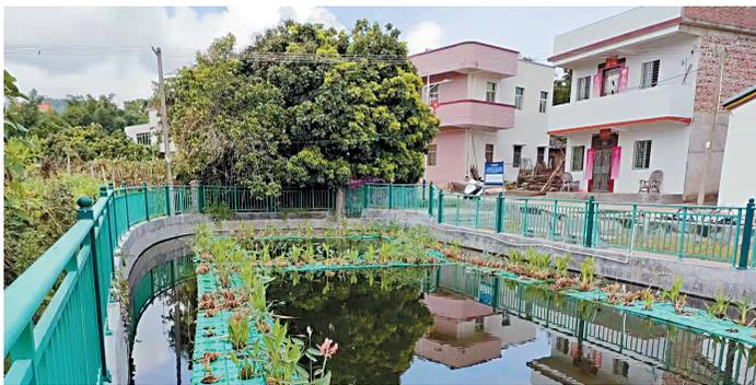
■人工湿地污水处理系统通过水生植物净化污水,维护运营成本不高。
