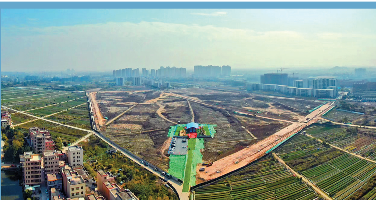
白云金控·汽车智能网联产业园项目所在地外景。
