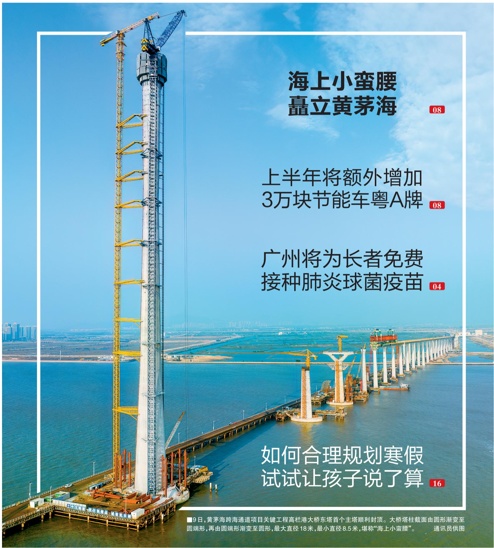
■9日，黄茅海跨海通道项目关键工程高栏港大桥东塔首个主塔顺利封顶。大桥塔柱截面由圆形渐变至圆端形，再由圆端形渐变至圆形，最大直径18米，最小直径8.5米，堪称“海上小蛮腰”。 通讯员供图
