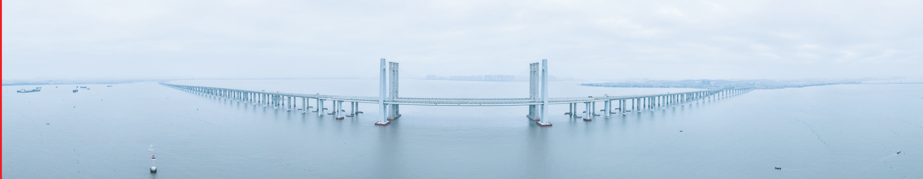
■2月4日拍摄的福厦高铁泉州湾跨海大桥(无人机合成照片)。新华社发
