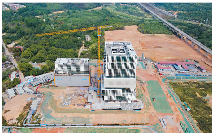
■世界气象中心粤港澳大湾区分中心项目现场。
