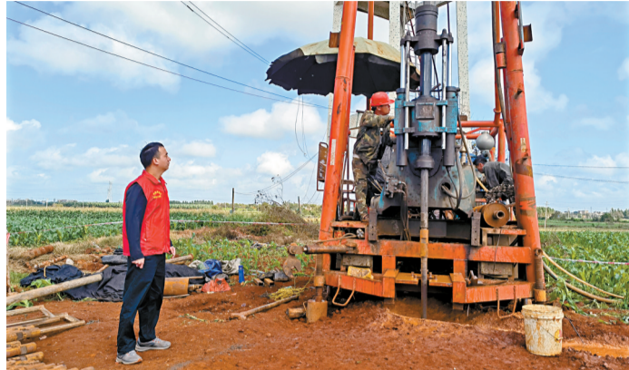
林耀到白坡 村查看集中供水 施工现场。
