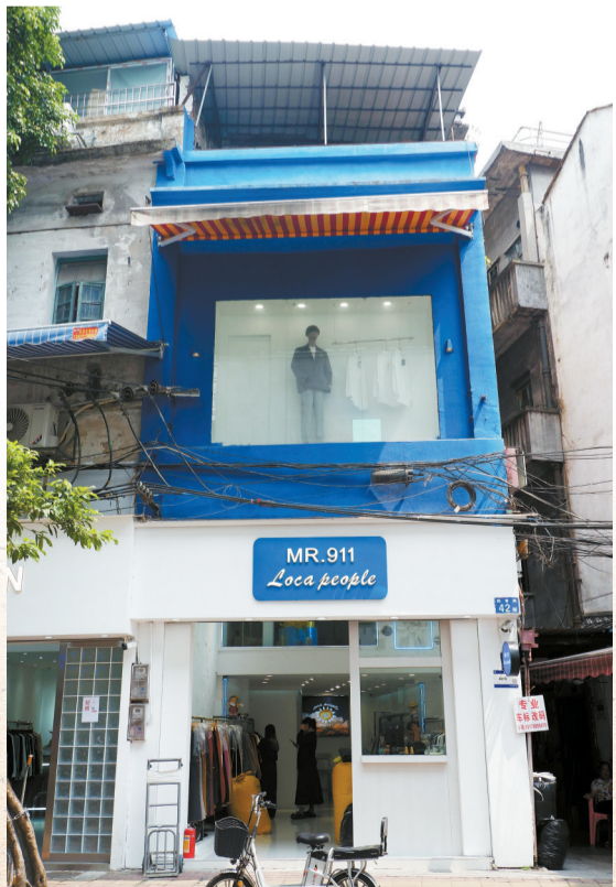
■传统风貌建筑线索杨巷路42号(上图:改造前;下图:改造后,二楼原门窗、铁艺栏杆全部被拆除,改造为玻璃橱窗,并被刷上蓝色涂料;一楼墙面被刷上白色涂料。)
