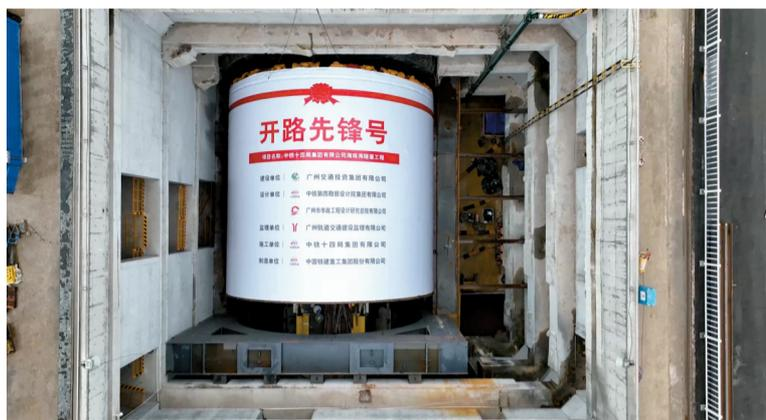
新快报讯 记者许力夫 通讯员 郑玉茹报道 14日,由广州交投集团投资建设、中铁十四局集团施工的海珠湾隧道工程东线隧道“开路先锋号”盾构机顺利始发,标志着珠江流域首条超大直径市政盾构隧道实现“双线”掘进,进入全面建设阶段。
