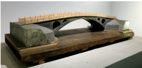
■赵州桥,石雕模型,尺寸:1350mm(长)×625mm(宽)×250mm(高),比例1:50
