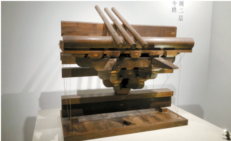
■山西大同善化寺普贤阁二层明间补间斗拱,斗拱模型,尺寸970mm(宽)×700mm(深)×950mm(高),基座970mm(宽)×550mm(深)×50mm(高),比例1:5
