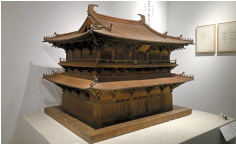
■天津蓟县独乐寺观音阁,建筑模型,尺寸1390mm(宽)×1090mm(深)×1130mm(高),比例1:20
