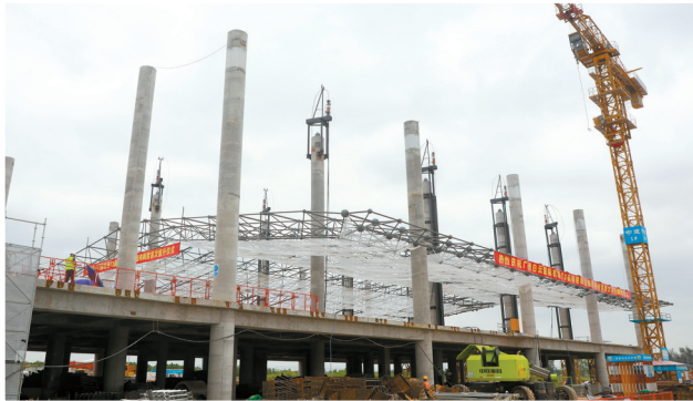
▲首榀钢结构网架在液压提升器的牵引下平稳垂直起吊,缓缓上升。 新快报记者 毕志毅/摄
