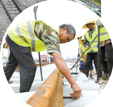
■6月15日,施工人员在龙龙高铁福建段铺轨施工现场装配钢轨扣件。 新华社发
