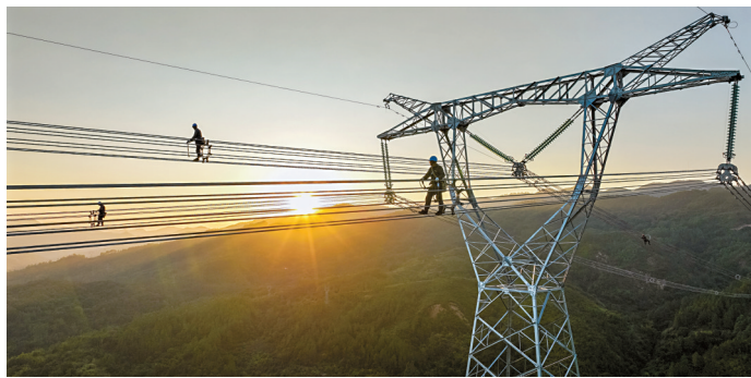
■高空作业人员对八分裂导线进行附件安装。
