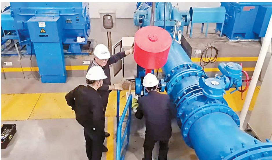
■水质监测中心工作人员对供水加压设施进行维护。
