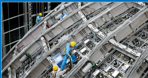
■工作人员在探测器的不锈钢结构上进行安装作业。
