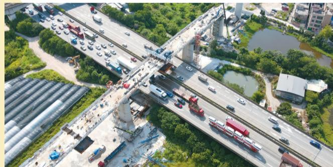
**新快报讯 记者许力夫 通讯员吕翀 方杰 邓联旭 周佳飞报道** 7月9日,跨越车流量繁忙的北二环高速,广州白云站枢纽配套联络线——京广高铁联络线一号特大桥主跨208米连续梁顺利合龙,标志着全线连续梁全部合龙,全线架梁铺轨通道实现贯通,为加快后续施工进度、保障白云站枢纽年底达到开通条件奠定基础。
