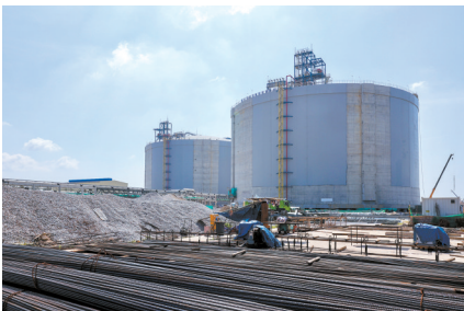
■潮州华瀛天然气接收站的三座全容式低温LNG储罐及其配套项目、配套码头等接近完工。
