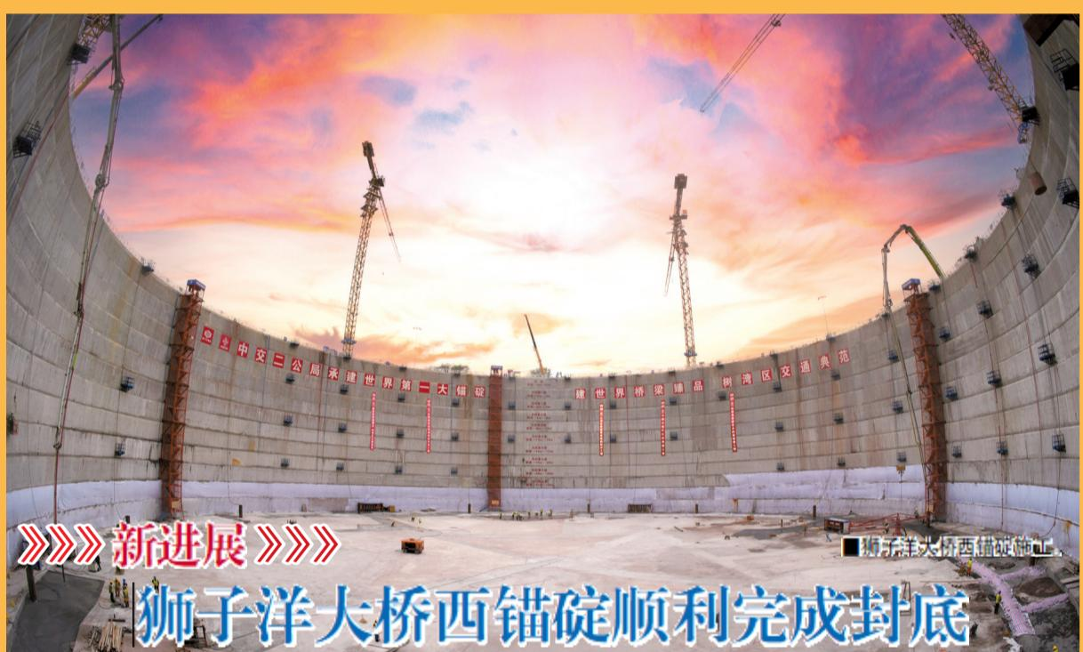
新快报讯 记者许力夫 通讯员粤交集宣 岳路建报道 一年之计在于春,广东交通集团狮子洋通道项目正在火热施工中,建设现场再次传来好消息:2月27日21时,随着一只只机械手臂来回移动,把最后一车混凝土浇筑入模,狮子洋大桥西锚碇宣告顺利封底,这是继2月初东锚碇完成封底施工后又一重大进展。
