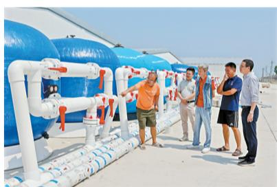
■对虾项目养殖车间外,4个蓝色大罐子并排而立,这套装置便是关系着对虾养殖品质的海水净化装置。
