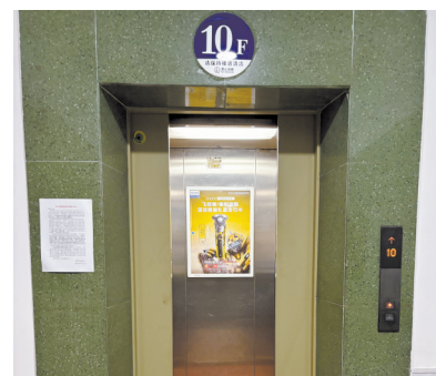
■丰景大厦的旧电梯已经“超龄”了。
