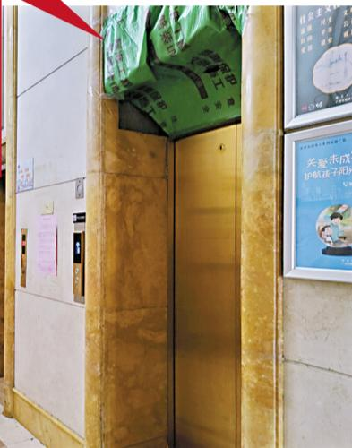
后,服务中心立即围蔽了电梯口附近的区域,清理脱落的石材碎片,现场设置了警示标志。维修专业经理制定了详细的修复方案,包括检查剩余石材的稳固性,对不稳固的石材进行加固或更换,最后将对整个装饰面进行更换。“目前,检查工作已全覆盖,修复工程的相
