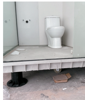
■卫生间做了抬高处理,地板下安有下水管道。
