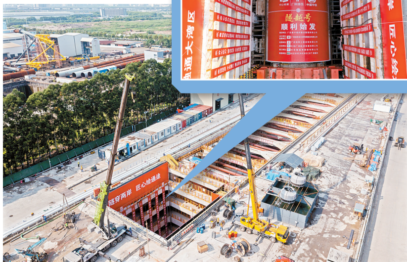
■8月28日,负责南珠(中)城际铁路“穿海”任务的“隧越号”盾构机顺利始发。
