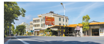
■官塘镇巷头村对象官路进行改造提升,打造餐饮旅游“致富路”。
