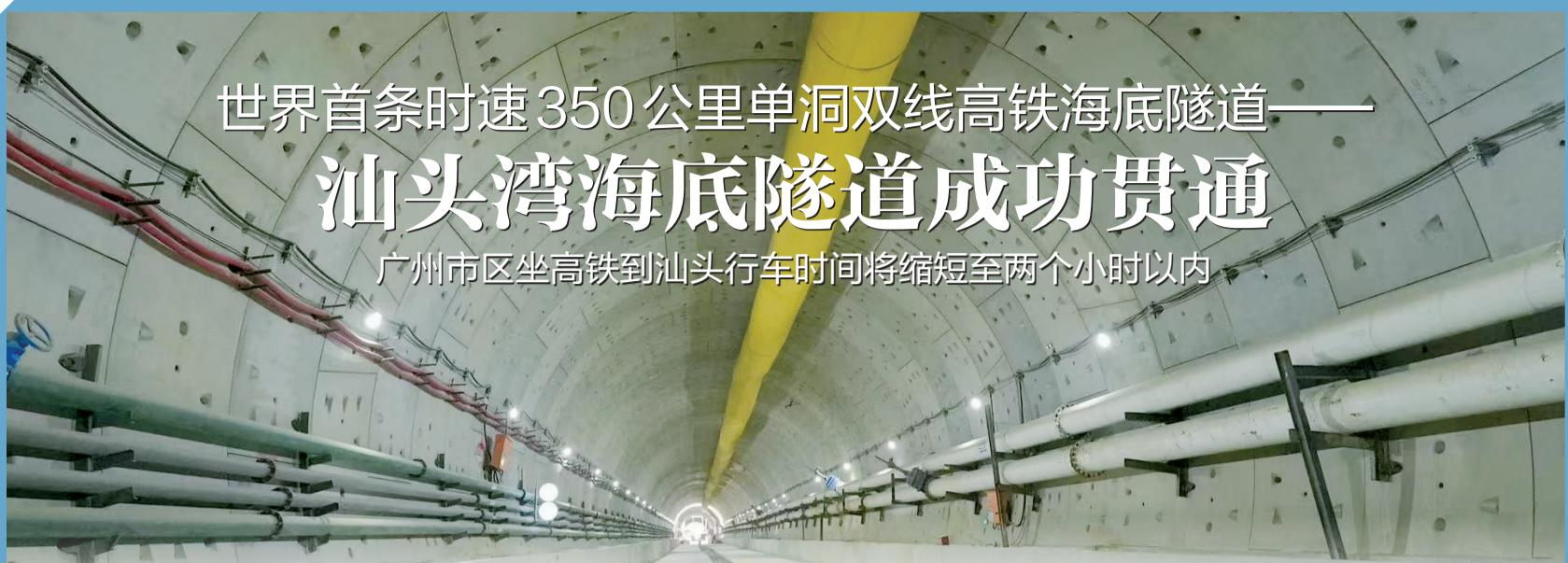
3月26日,在汕头湾海底68米深处,随着“永平号”盾构机近5层楼高、直径14.57米的刀盘破岩而出,世界首座时速350公里单洞双线高铁隧道——汕头湾海底隧道成功贯通,标志着连接汕头与汕尾的“黄金通道”取得突破性进展,创造了国内外海底隧道建设多项纪录。汕头湾海底隧道的顺利贯通,为汕汕高铁全线如期开通运营打下了坚实的基础,以后由广州坐高铁到汕头将比现在更快。
