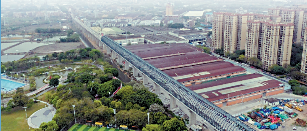
■建设中的广湛高铁全封闭式声屏障。通讯员供图
