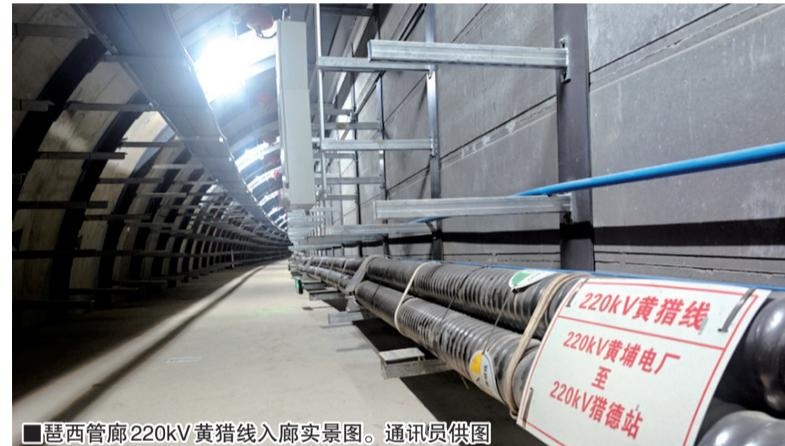
■琶西管廊220kV黄猎线入廊实景图。通讯员供图
