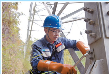
■杨柳辉在拆卸输电杆塔接地引下线,准备测量接地电阻。
