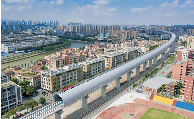
■已完工的广湛高铁高中立交特大桥“隔音隧道”。
