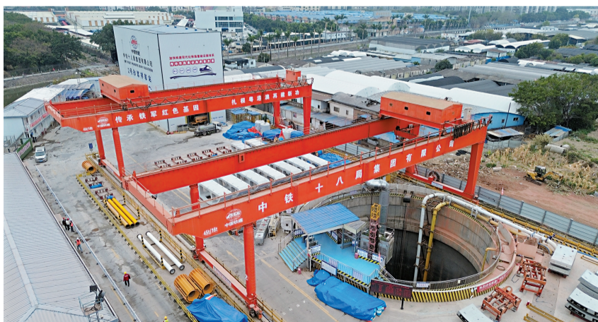
■广州站至广州南站联络线关键控制性工程——西塍隧道施工现场。
