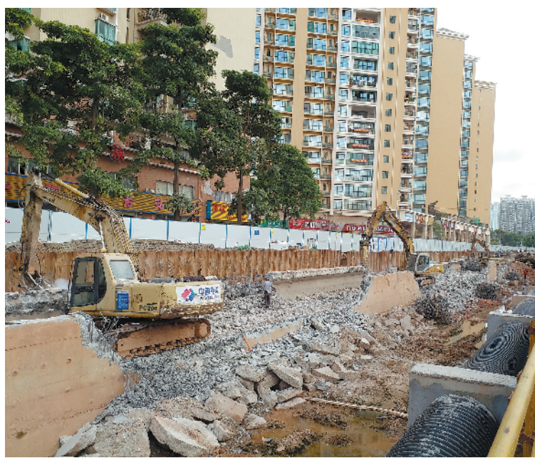
施工中的“正本清源”工程
