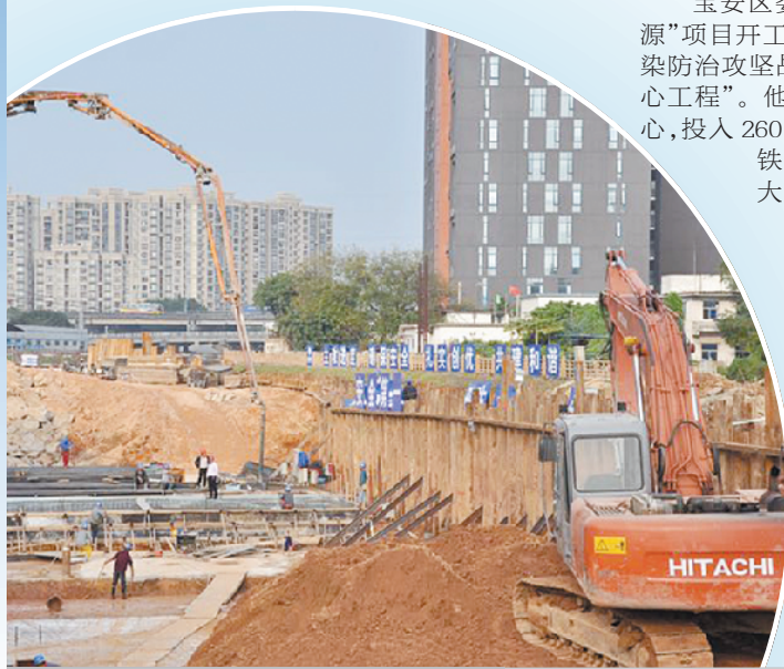
宝安区治水提质工程工地,工人在争分夺秒施工
