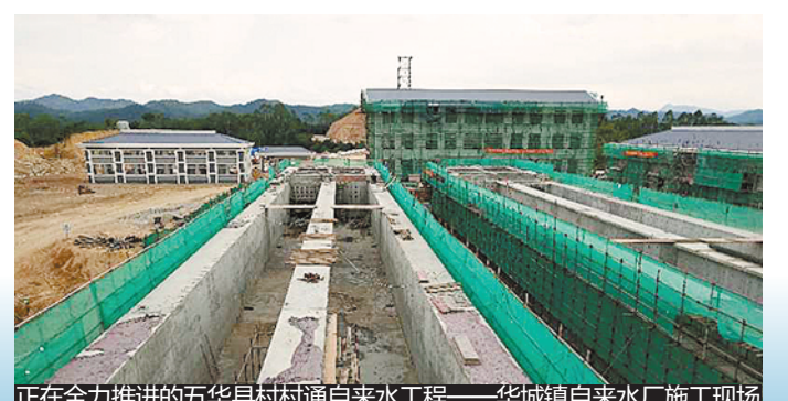
正在全力推进的五华县村村通自来水工程——华城镇自来水厂施工现场
