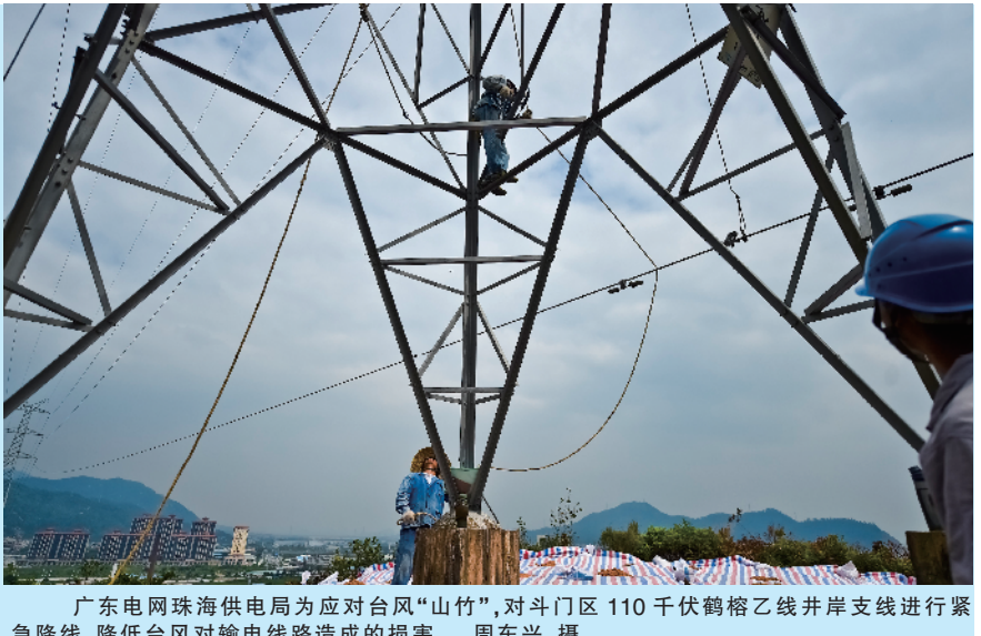
广东电网珠海供电局为应对台风“山竹”,对斗门区110千伏鹤裕乙线井岸支线进行紧急降线,降低台风对输电线路造成的损害。周东兴 摄
