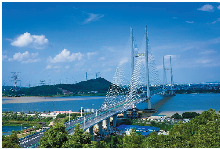
江顺大桥是改革开放四十年间江门的重大交通建设之一
