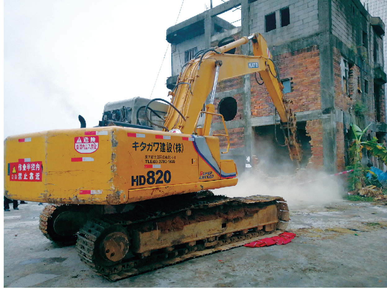
10栋烂尾楼被拆除
