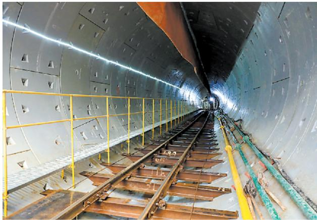
珠江三角洲水资源配置工程采用全封闭深层地下输水方式,输水隧洞位于地下40米-60米处
