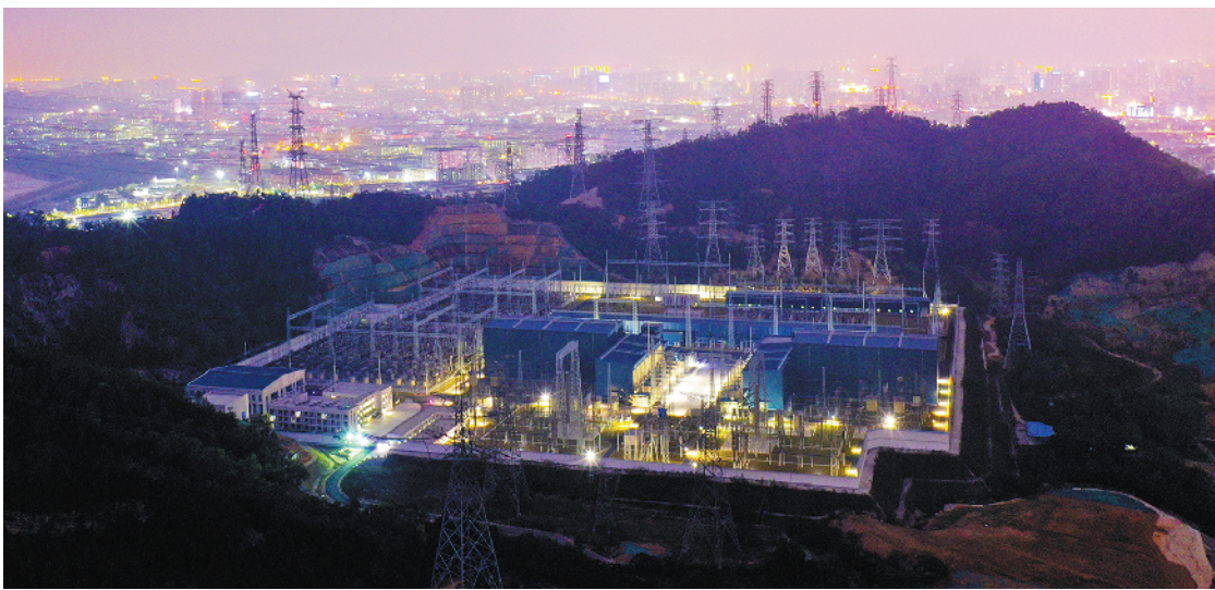
滇西北直流工程受端站东方换流站 南方电网超高压公司供图
