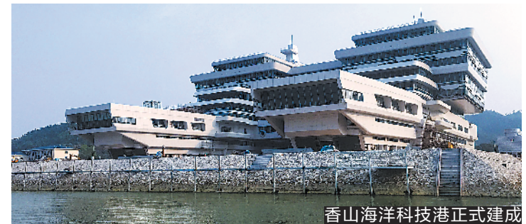
香山海洋科技港正式建成
