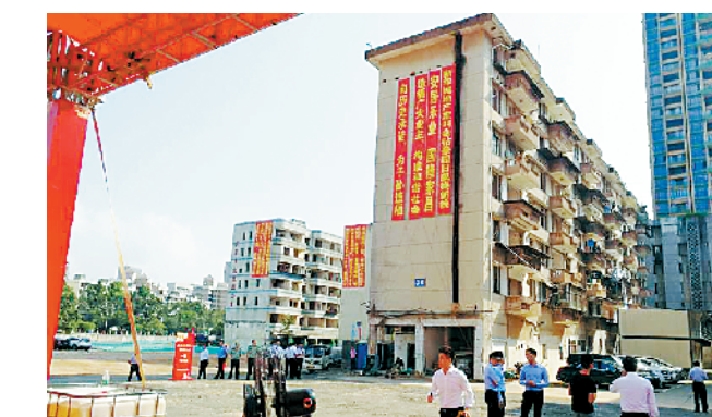
深圳旧改项目金钻豪园一期动工
