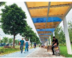
站为中心,向周边的水西路、开创大道、汇星路、香雪大道、香雪一路、香雪二路、香雪三路、香雪五路、开萝大道、萝平路、笃学一横路、峻福路等13条道路延伸,最终形成15.8公里的风雨连廊系统。公示信息显示,该系统将包括宽3米至4米高、3米至3.5米的连廊主体,照明工程、道路、绿化破除修复及相关配套工程等。公示信息称,“风雨连廊是城市慢行系统的重要组成部分,项目建设能够完善城市慢行系统,满足周边居民日常出行、休闲需求,创造优良的公共服务环境,构造特色城市景观,提升城市公共配套设施和空间品质。”
