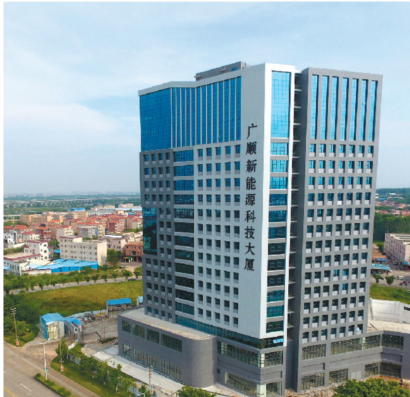
位于丹灶境内的广顺新能源科技大厦
