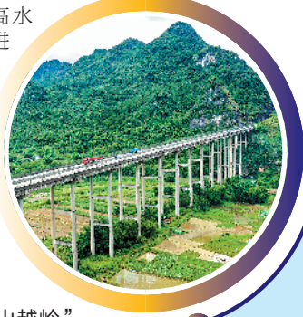
杜步大桥“穿山越岭”
