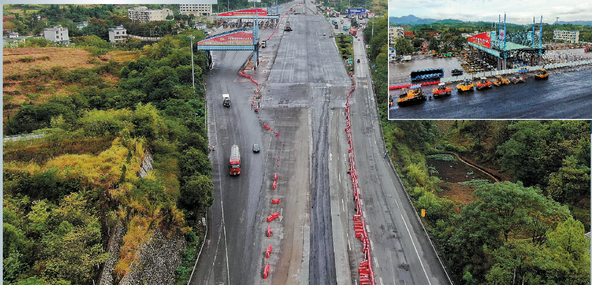
京珠北高速粤北站已拆除前后广场主线 14 条车道,并完成正线取直,恢复沥青路面。取直改造的车道目前仍封闭 羊城晚报记者 汤铭明 摄
