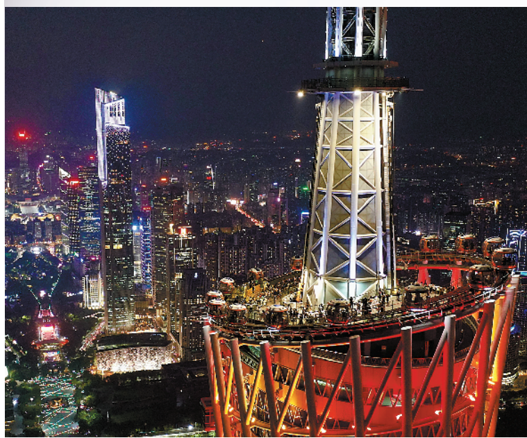
从广州塔顶端可见广州中心城区繁华夜景
