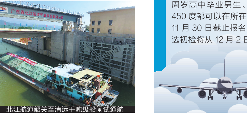
北江航道韶关至清远千吨级船闸试通航
