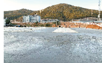
新建的梅州西站停车场
