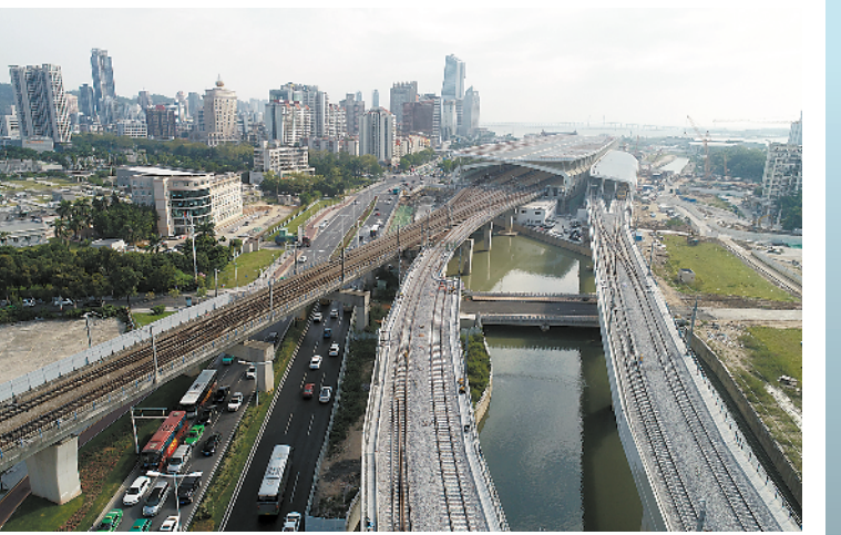
珠机城轨一期珠海站为高架车站 受访者供图
