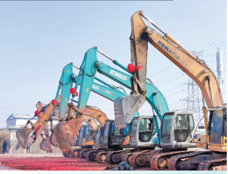
▲本次集中开工的东莞市重大项目共43个
