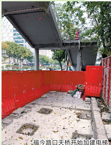
福今路口天桥开始加建电梯
