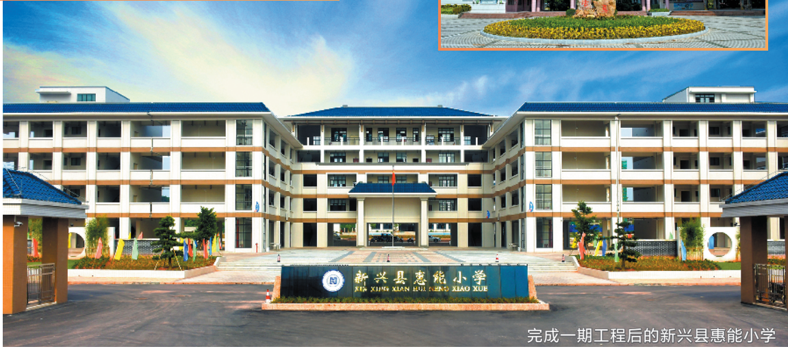
完成一期工程后的新兴县惠能小学
