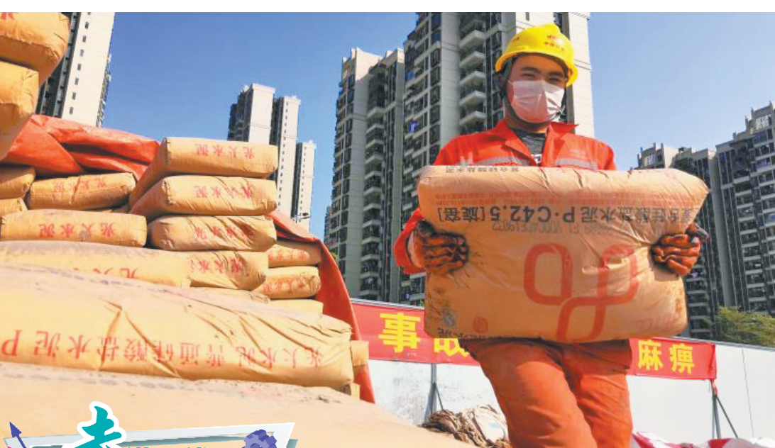
黄埔有轨电车项目作业人员搬运水泥 通讯员 李佳珊 供图
